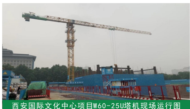
西安国际文化中心项目W60-25U塔机现场运行图
